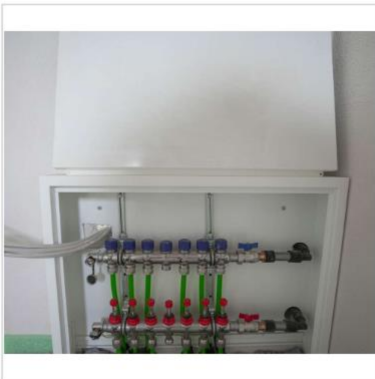
Verteilung Fußbodenheizung OG
